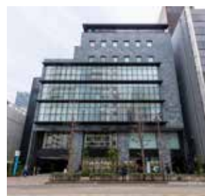
2020年2月 新本店ビル移転グランドオープン (横浜市中区尾上町)
